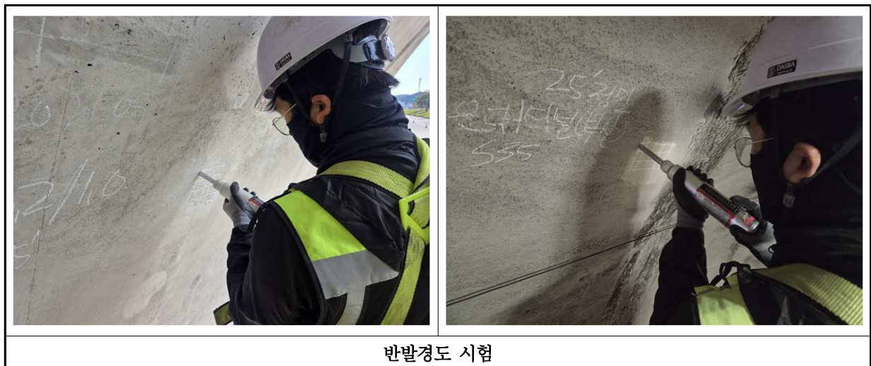
【사진 7.4.1】 강도시험 현장사진
