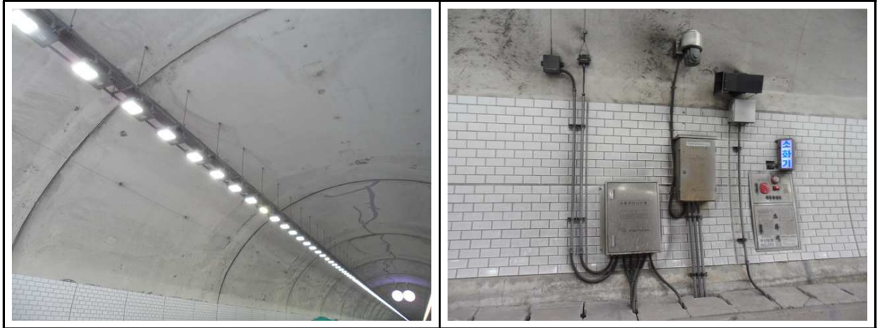
【사진 7.3.17】 기타부속시설 전경
