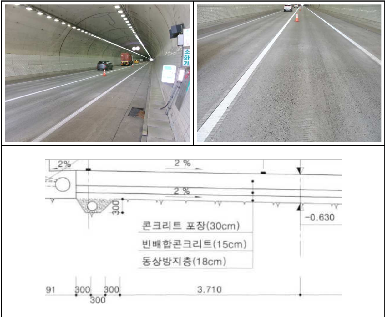
【사진 7.3.15】포장부 전경
